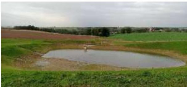
In einem Geländeeinschnitt südlich der Ortslage Blankensteins werden durch gezielte Einzelmaßnahmen Rückhalteräume für die gefährdete Arterhaltung des Kammmolches angelegt. Diese Becken sollen bei Starkregen das Wasser auffangen und zeitverzögert an den Seitenarm der Triebisch abgegeben wird.
