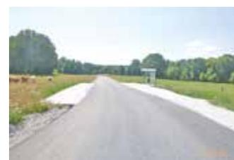
Foto). Bestandteil des 2. Teilabschnitts war die Absenkung der Kuppe vor der Ortslage Dürrröhrensdorf-Dittersbach. Im Zuge des Straßenbaus erneuerte der WAZV „Mittlere Wesenitz“ in der Ortslage Dürrröhrensdorf-Dittersbach den Regenwasserkanal, ordnete die Oberflächenentwässerung neu und führte in der Ortslage Dürrröhrensdorf-Dittersbach Arbeiten an der Trinkwasserleitung und den
