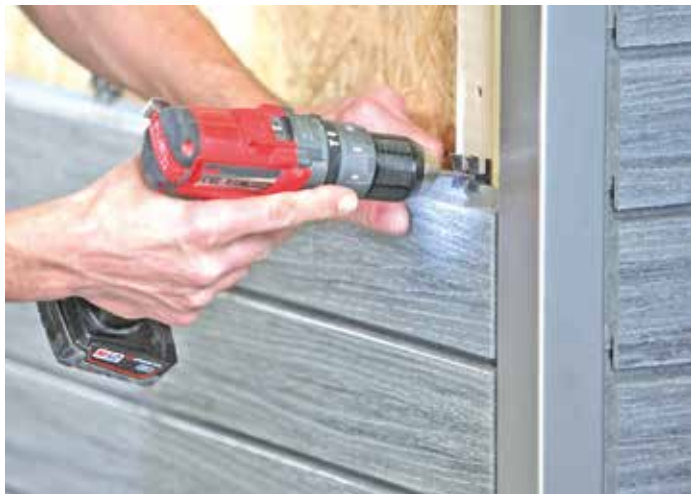
Fassadenprofile werden mit einer Nut- und Spundverbindung formschlüssig auf einer Holzunterkonstruktion angebracht.
