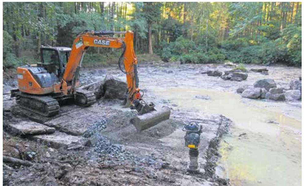
Bei der Entschlammung eines Teiches kommen Bagger und Baumaschinen zum Einsatz. Der Aushub wird nach Möglichkeit im Uferbereich eingebaut.
