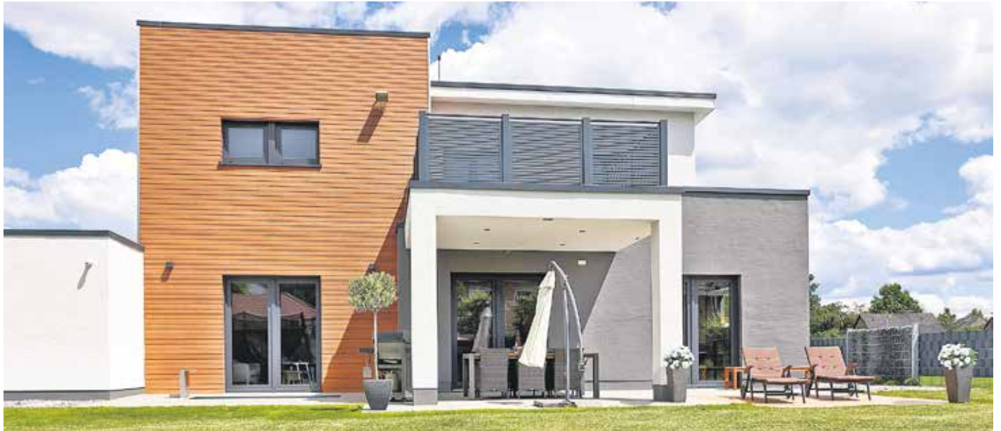
Eine Fassade kann auch in mehreren Farben und unterschiedlichen Elementen gestaltet werden.
