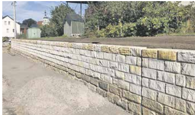
Die Stützwände sind fertiggestellt
