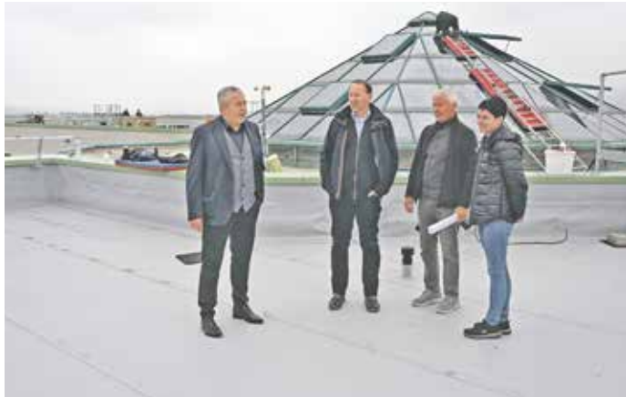
Landrat Michael Geisler (li.) macht sich ein Bild vom Baufortschritt, hier mit Schulleiter Igor Bastian und Vertretern des Planungsbüros auf dem Dach des BSZ „Friedrich Siemens“ Pirna-Copitz.
