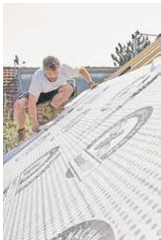
Ein Dachausbau ist eine gute Gelegenheit, gleichzeitig eine effiziente und nachhaltige Dämmung vornehmen zu lassen.
